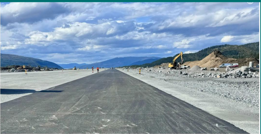
Fra arbeidet med byggingen av ny flyplass i Mo i Rana. Foto: AF Gruppen
